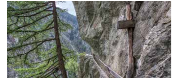
Der Bau von Suonen war enorm aufwendig und oftmals auch gefährlich.
