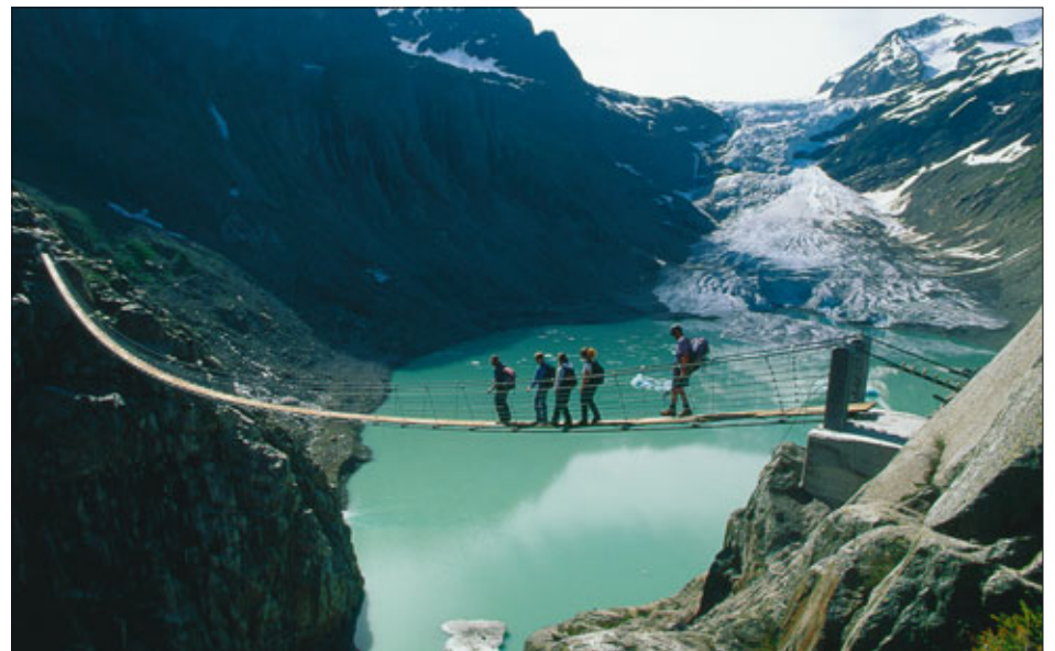
Spektakulär. Die Trift-Hängebrücke ist zum Begehen genau so spektakulär wie sie aussieht, aber völlig sicher.
